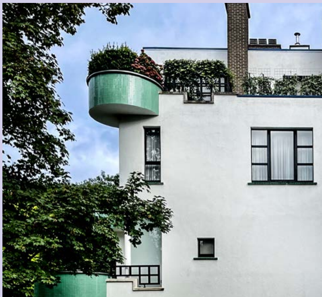
Résidence La Galaxie, 37-37a avenue de l'Observatoire. Architectes: Jean-Pierre Blondel, Pierre Blondel et Odette Filippone, 1987.
